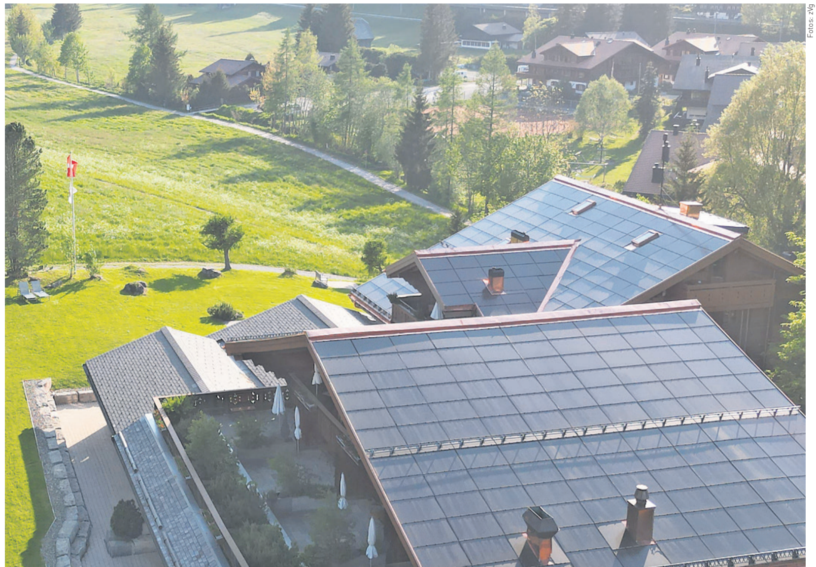
Keine halben Sachen: So wie diese beiden Dächer erscheinen noch zwei weitere des Hotelbetriebes in neuem Solarmodulkleid. Auch die Aufnahmen der Hornberg-Livecam verraten die zukunftsorientierte Neuerung.
